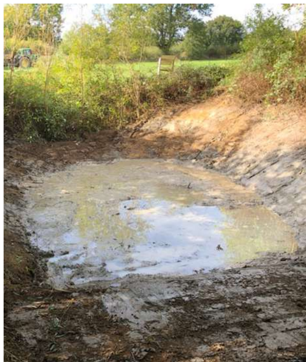
Restauration des deux mares situées aux Chaponneaux
